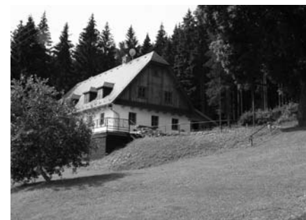
Stará horská chalupa prošla vhodnou rekonstrukcí, která zachovala tradiční vzhled (Malá Morávka)
